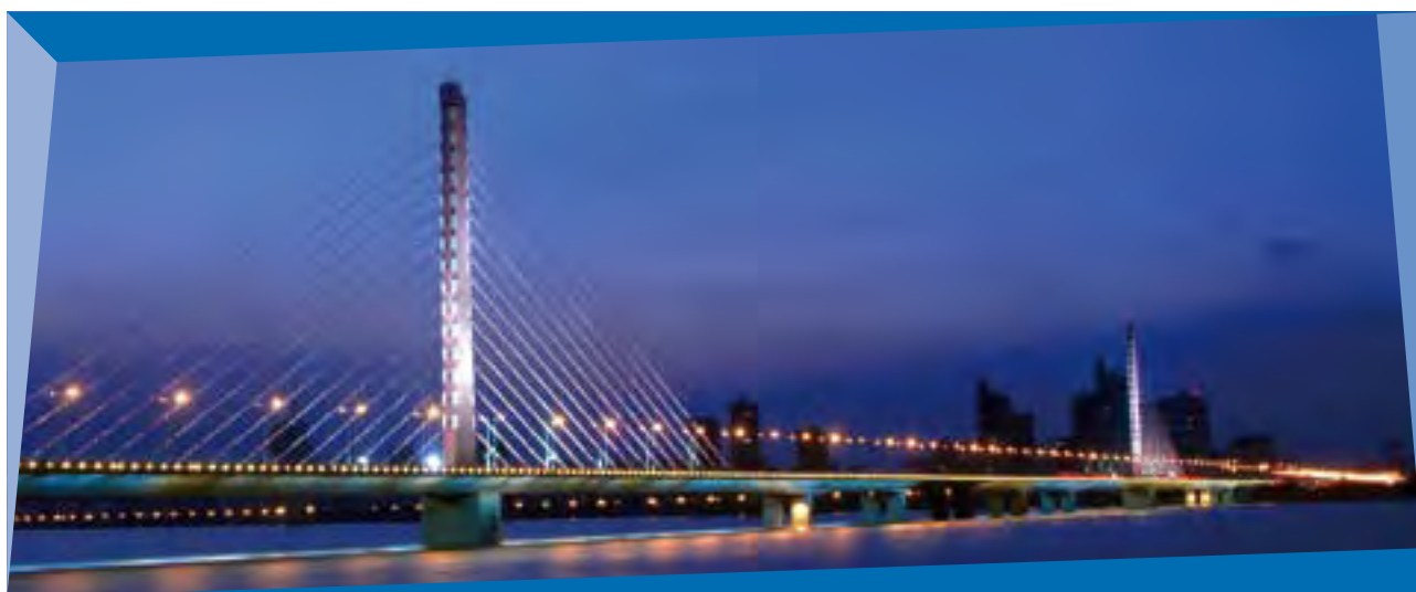
杭州錢江三橋
